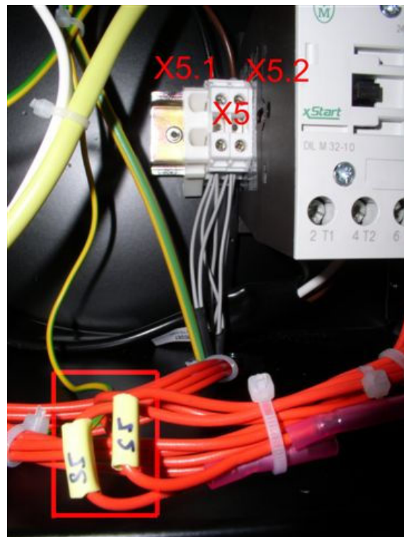
Umístění konektoru X5 a propojovacích dutinek S5. – Location of the X5 connector and of the cable connectors S5.
